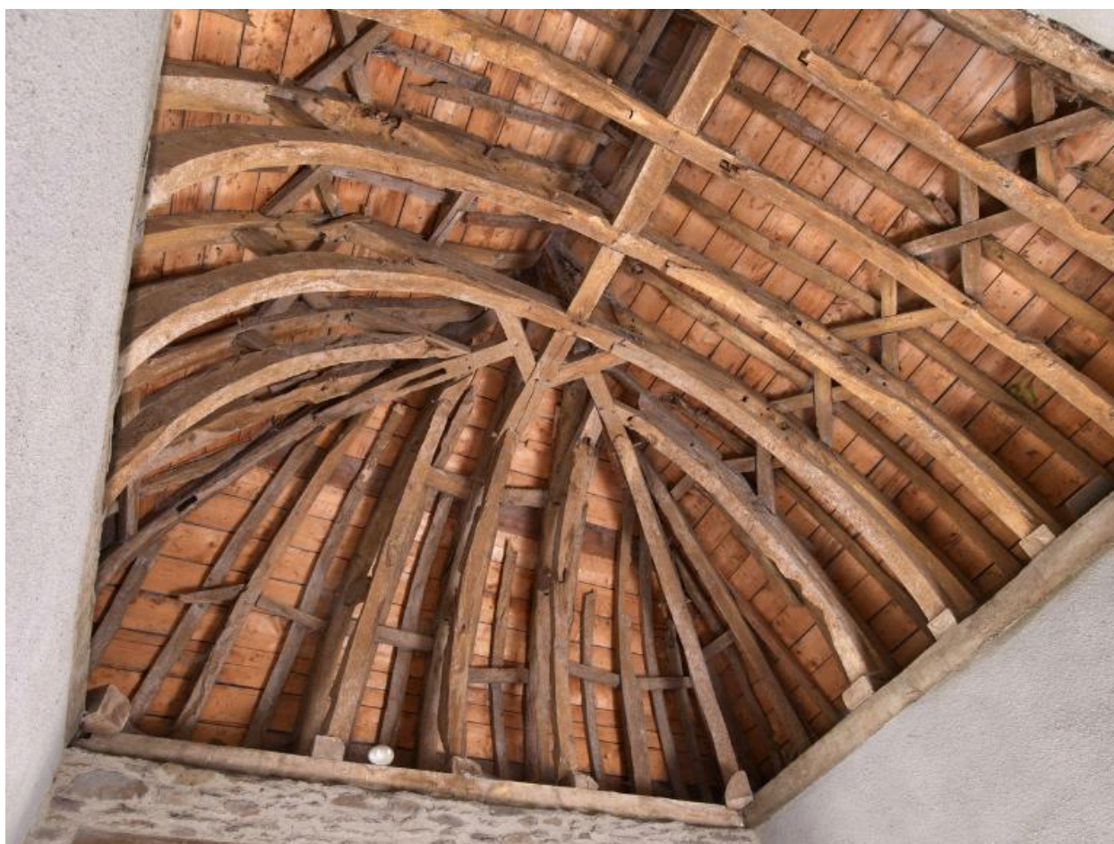
Porche ouest : vue de la charpente
