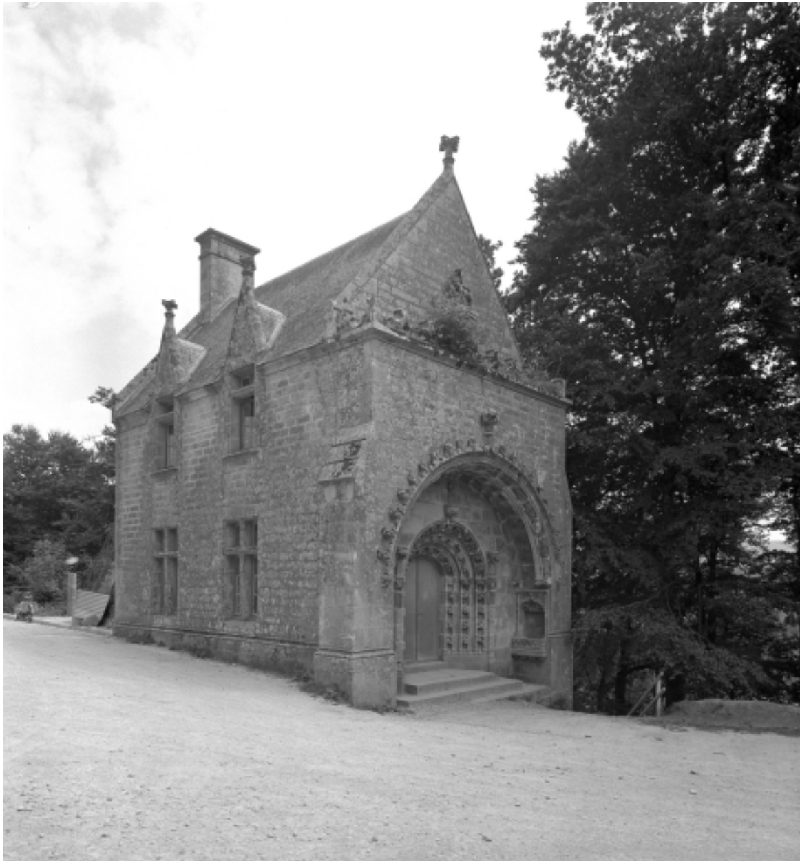
Châteauneuf-du-Faou, chapelle Notre-Dame-des-Portes : vue générale nord-ouest, état en 1966
