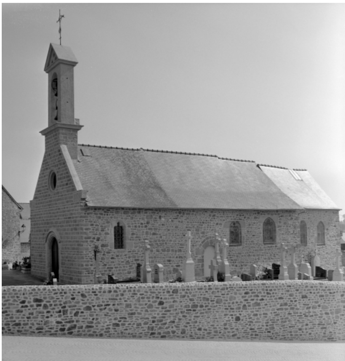
Élévation Sud-Ouest : vue générale
