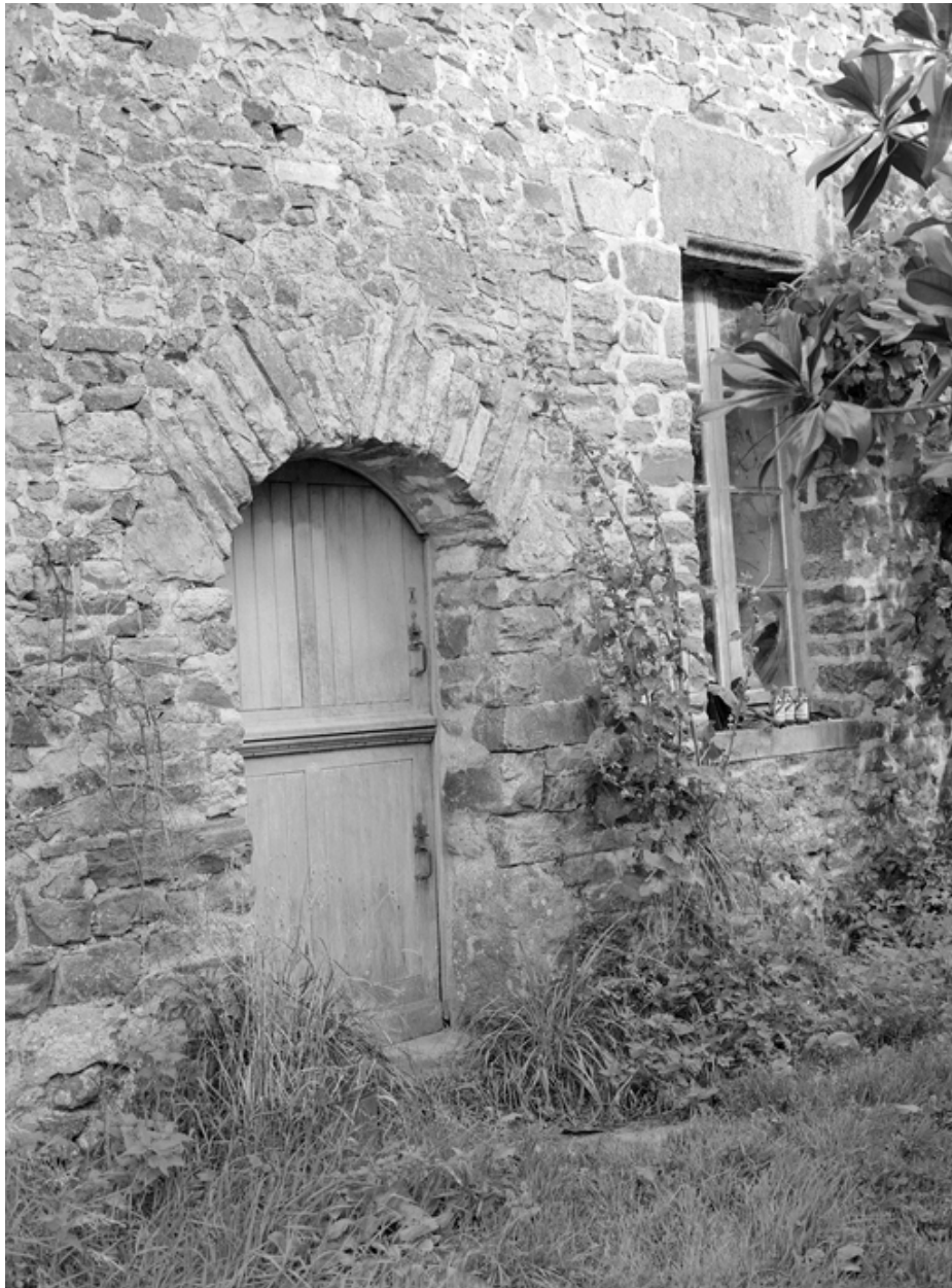
Vue de détail de la porte de la ferme.
