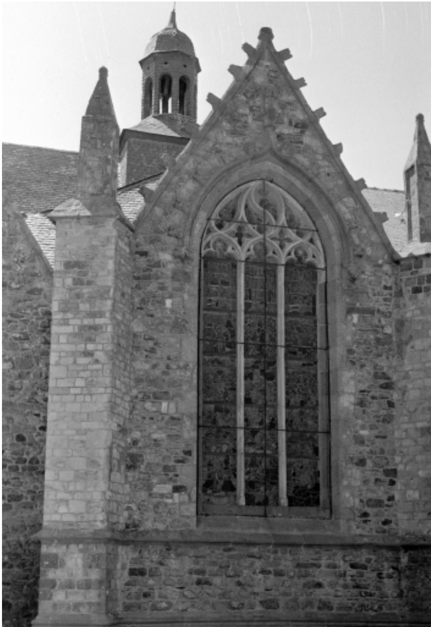
Vue générale d'un côté de la toiture avec vitrail.
