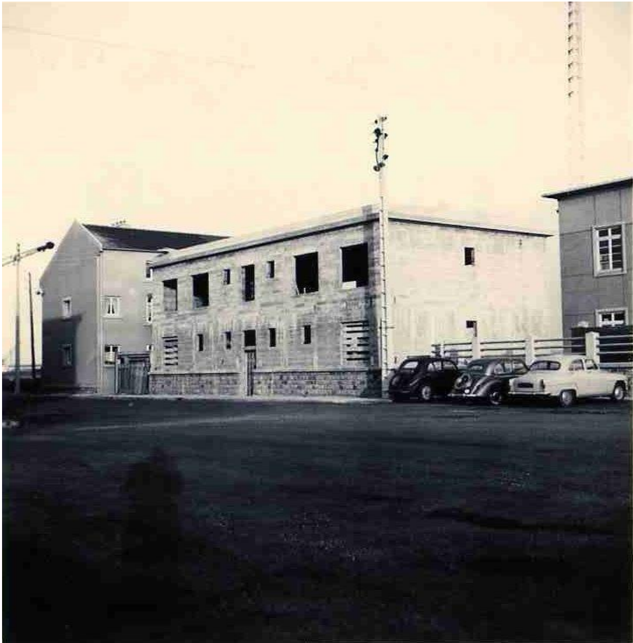
Logement des mécaniciens stagiaires, élévation nord, en cours de construction (10/05/1956)
