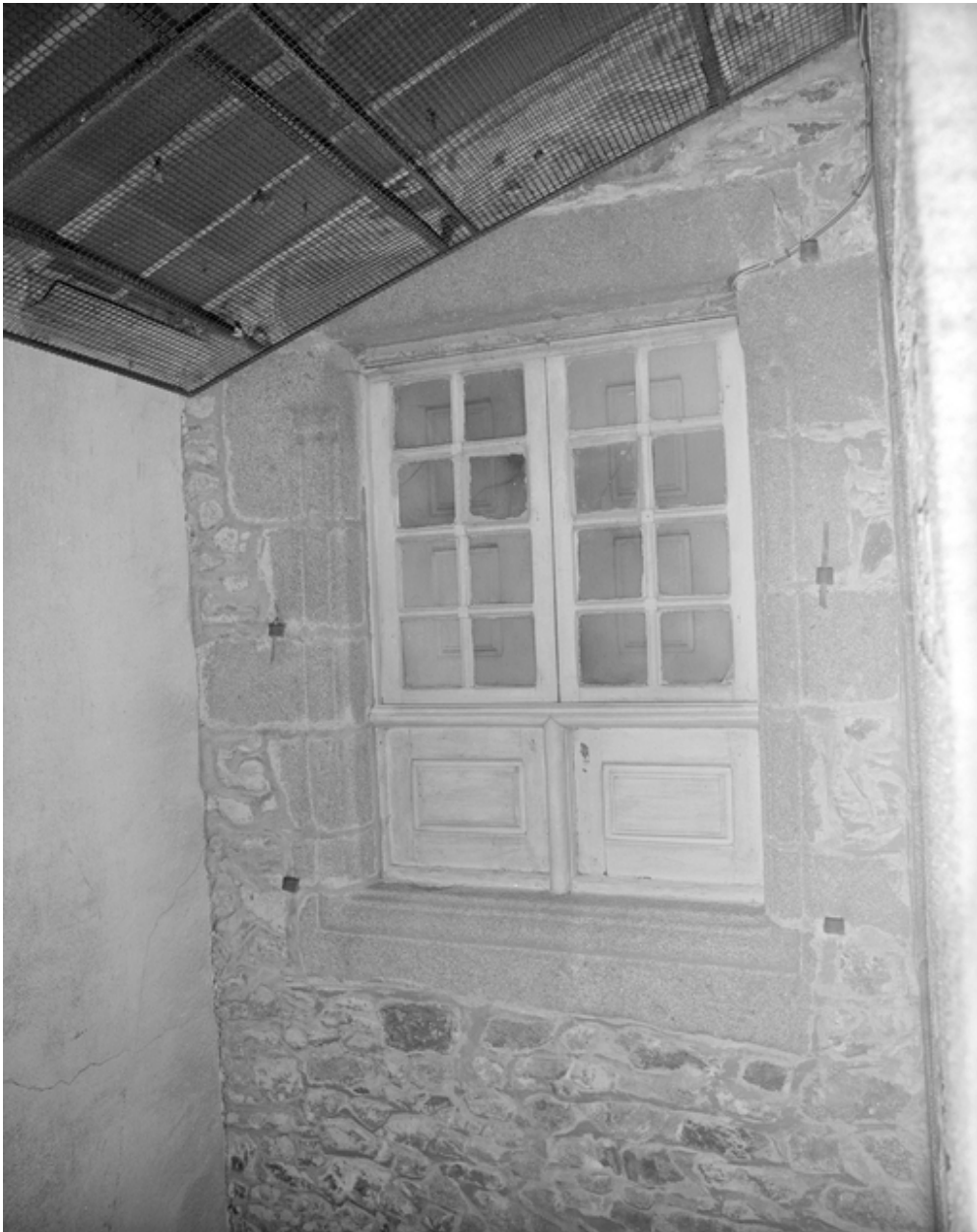
37 rue Nationale, vue de la fenêtre du XVIIe siècle prise de l'escalier à l'étage.
