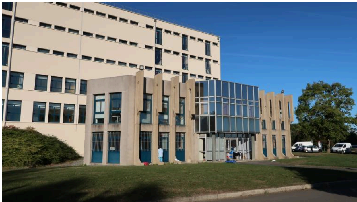
Actuelle infirmerie (bâtiment A1, construit pour être un foyer des internes) : vue prise du sud-est. Jean Bouget, architecte (plans 1989).
