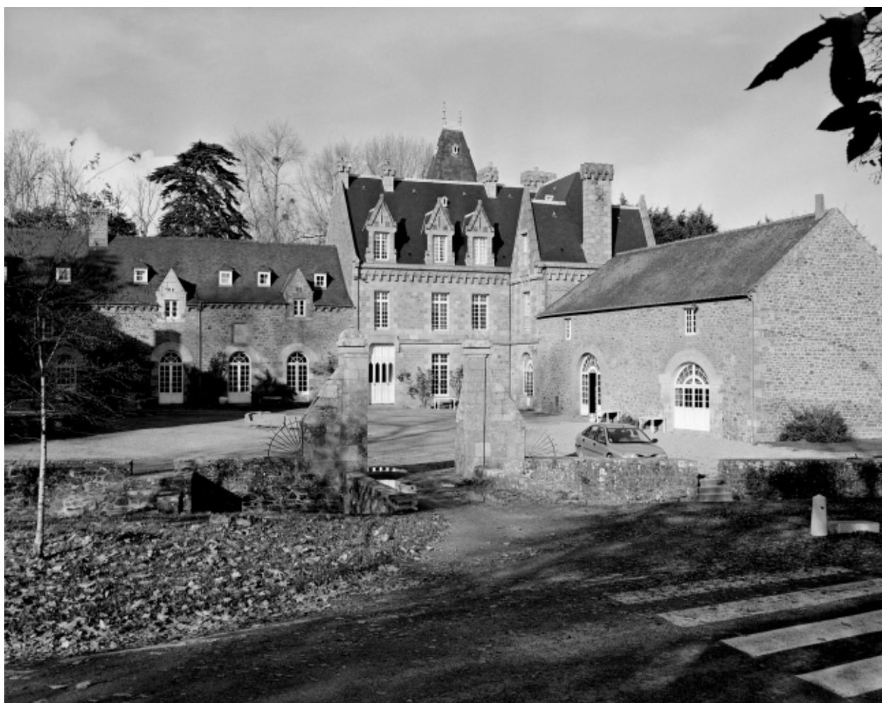
Vue d'ensemble des façades antérieures.
