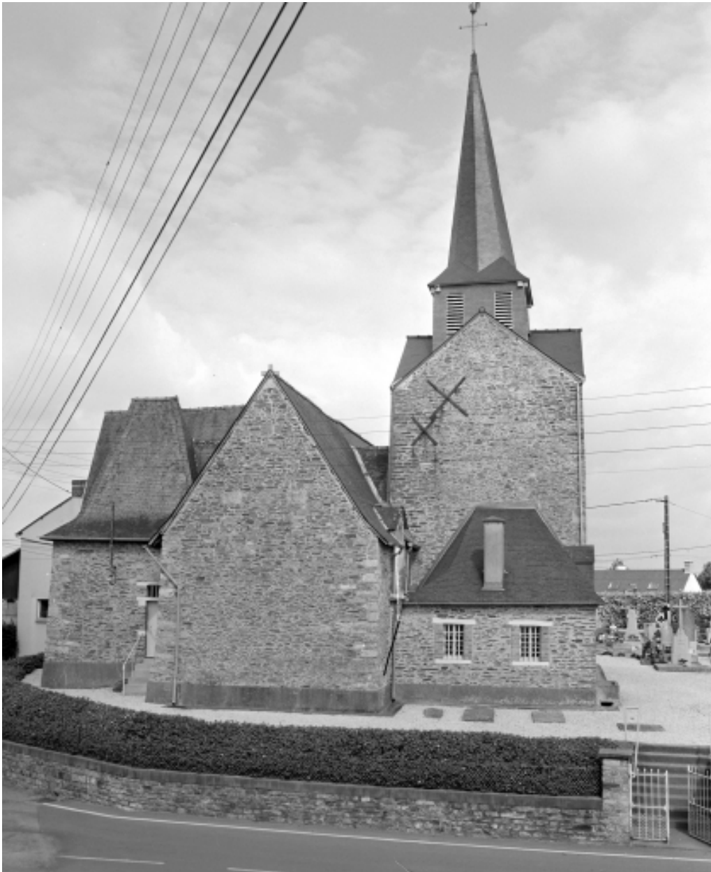
Elévation Est : vue générale
