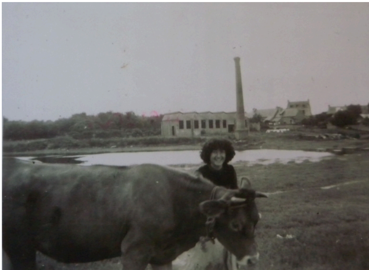
Vue des nouveaux bâtiments avec une toiture en sheds, construits par le chantier Bonne, 2ème quart 20ème siècle (collection particulière)
