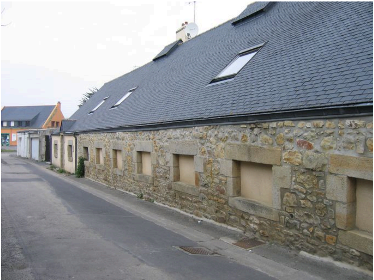
Vue arrière de l'ancienne conserverie
