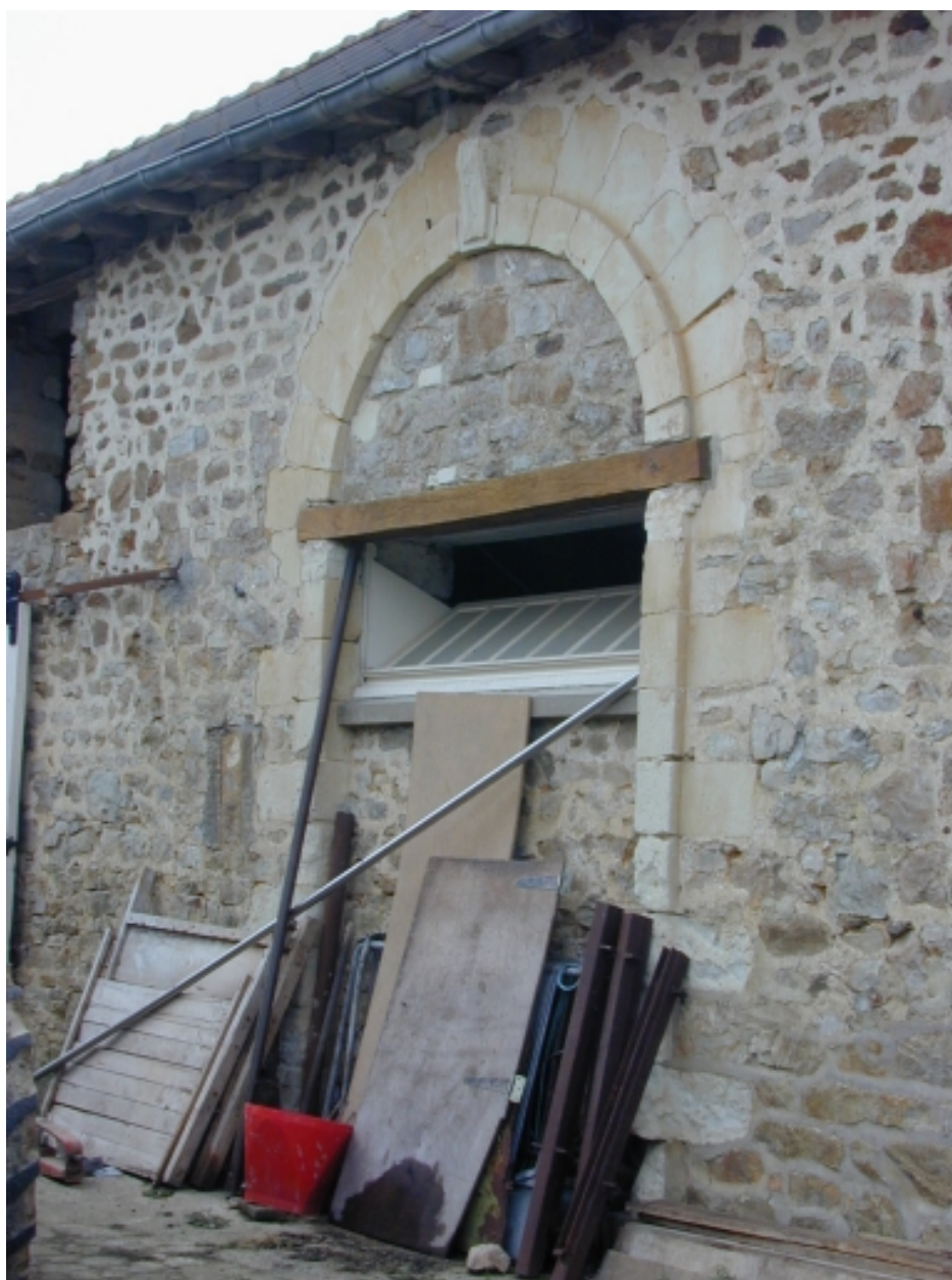
Porte d'entrée de l'orangerie
