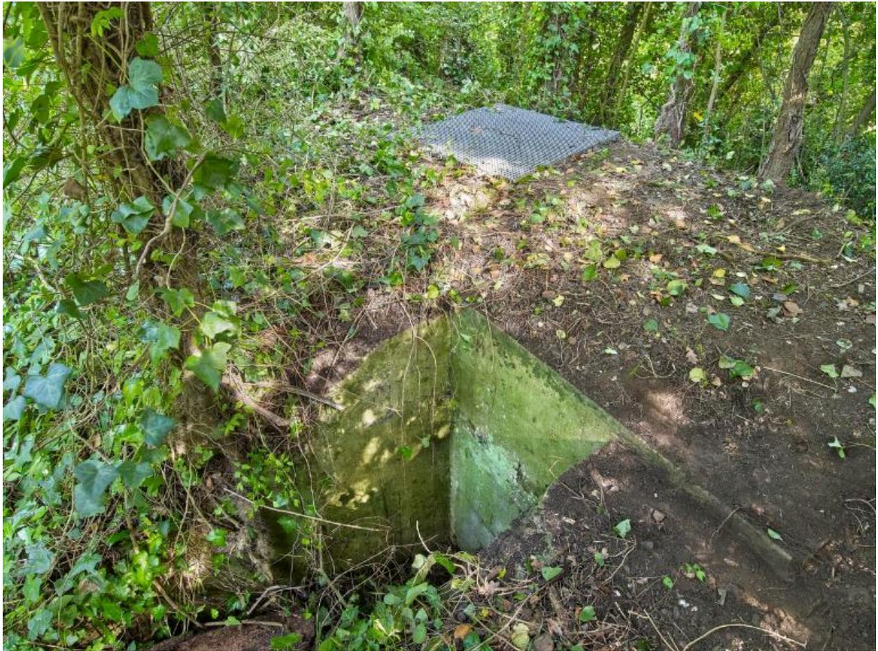
Vue du bunker - poste d'observation et de tir de type 58c dit Tobruk-Stand implanté au Sud près du bunker - casemate de type 680. Son entrée est murée par des parpaings. Une grille protège le poste d'observation et de tir circulaire des risques de chute
