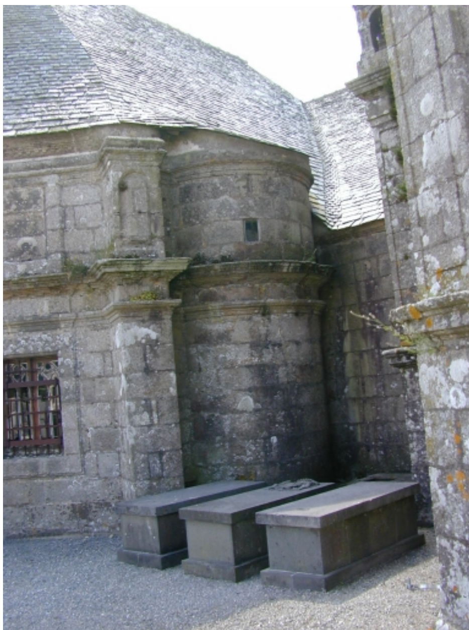
Sacristie : détail de la tourelle d'escalier
