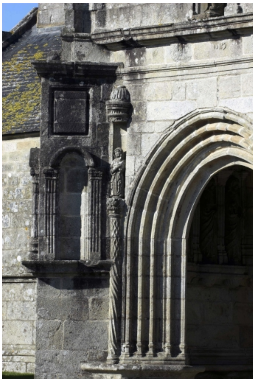
Porche, détail de la partie ouest
