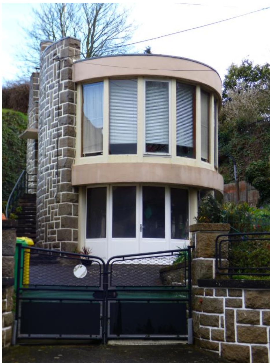
Vue de la façade d'entrée sur le boulevard Paul Doumer
