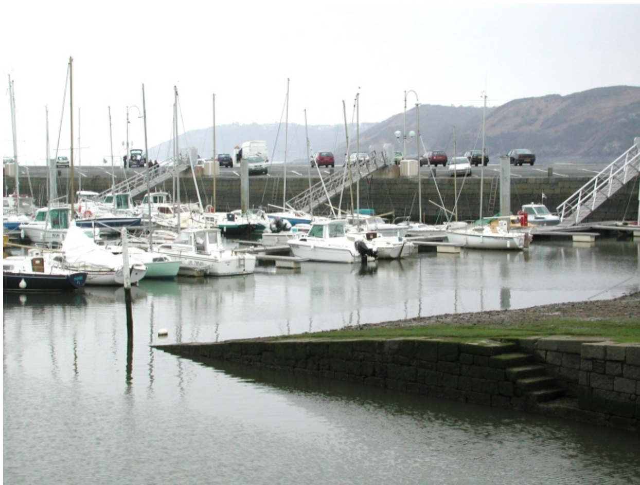
Vue de l'ancienne cale de carénage en amont du bassin, du côté du quai de Pordic
