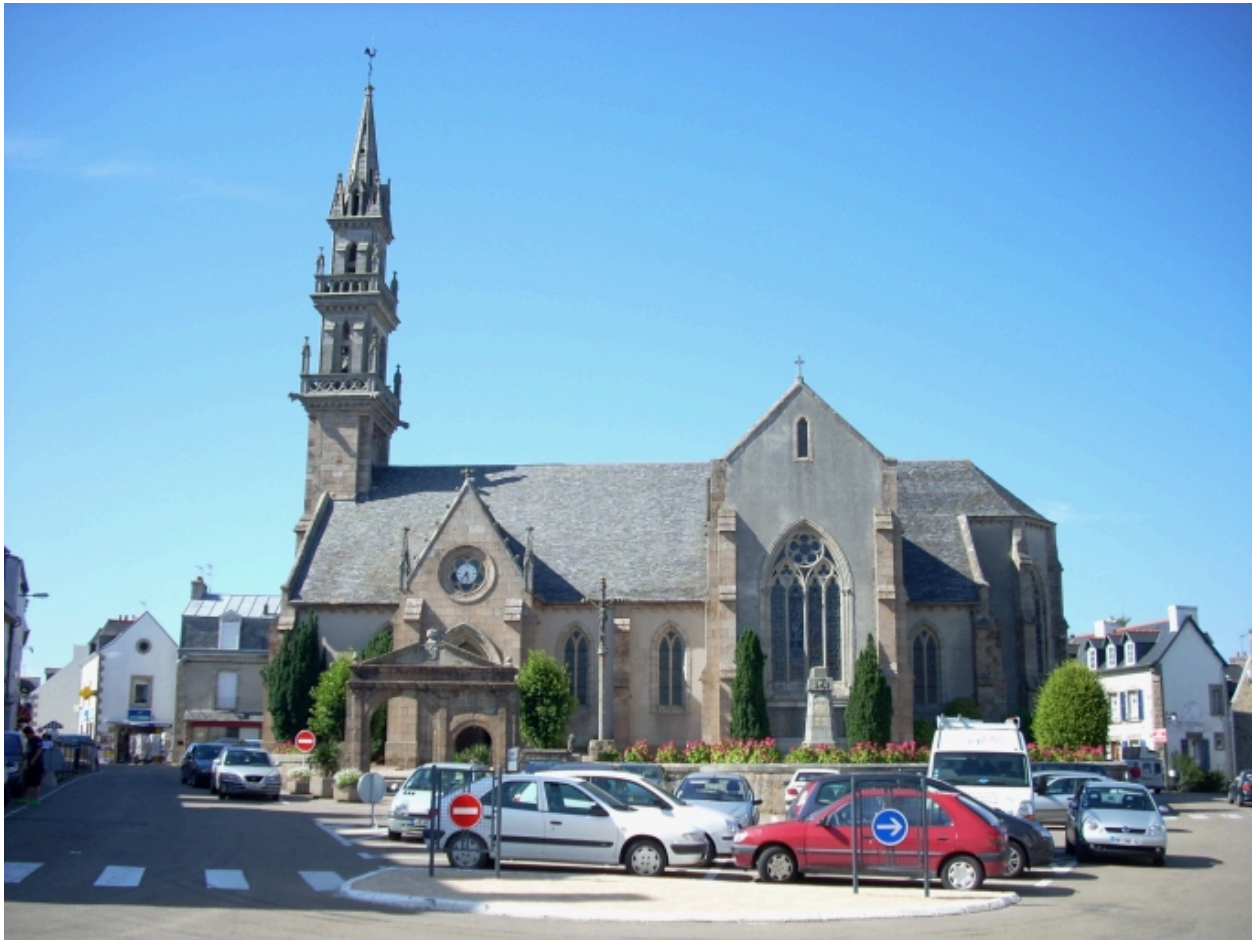
Carantec, église paroissiale Saint-Carantec : élévation sud
