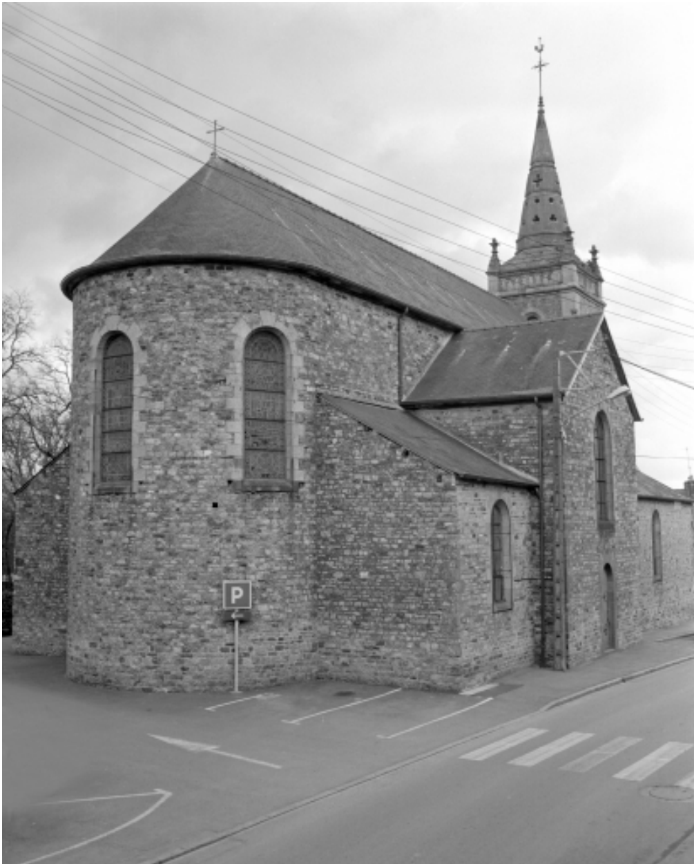
Chevet : vue générale sud-ouest
