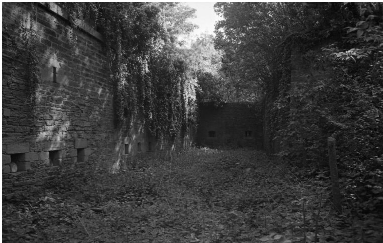
Enceinte de ville - Réduit B, élévation postérieure
