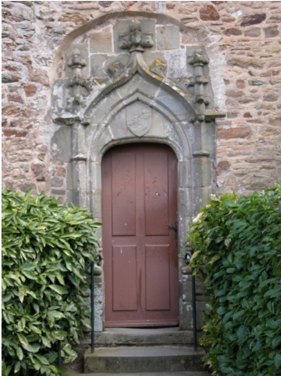
Détail : porte ; transept nord, mur ouest
