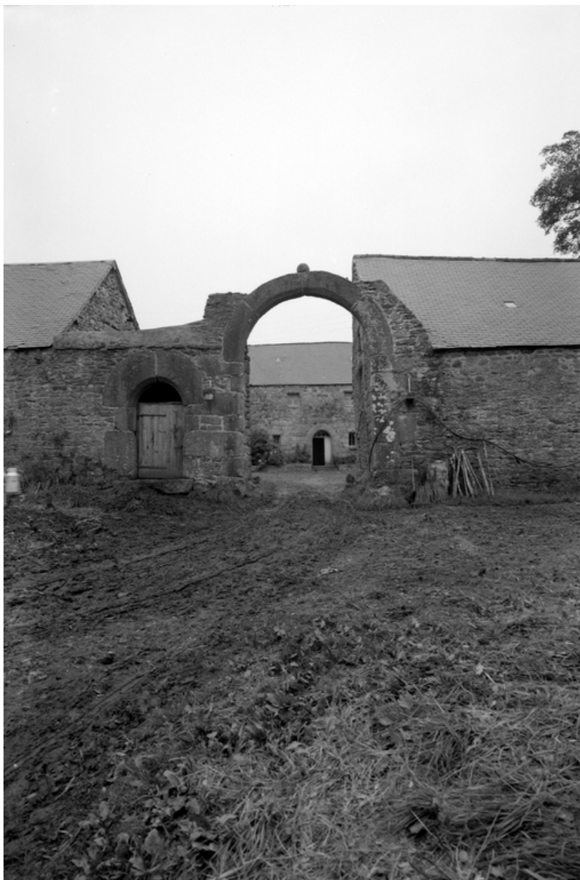
Vue de l'entrée vers le nord
