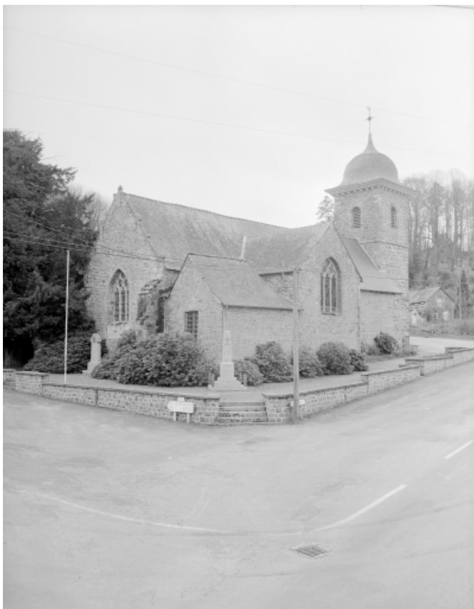
Elévation Nord-Est : vue générale.
