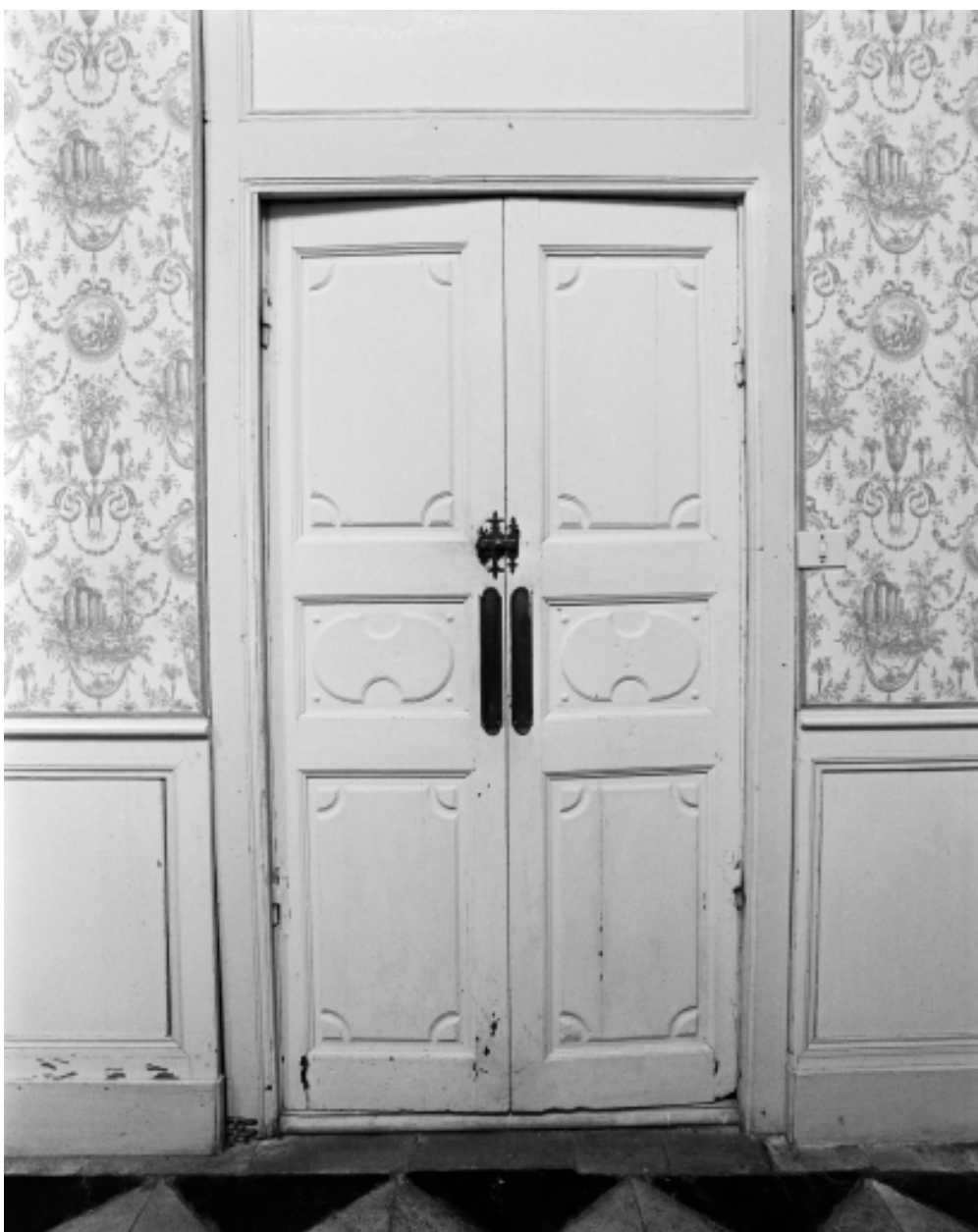
Logis, rez-de-chaussée, couloir : vantail de la porte sud
