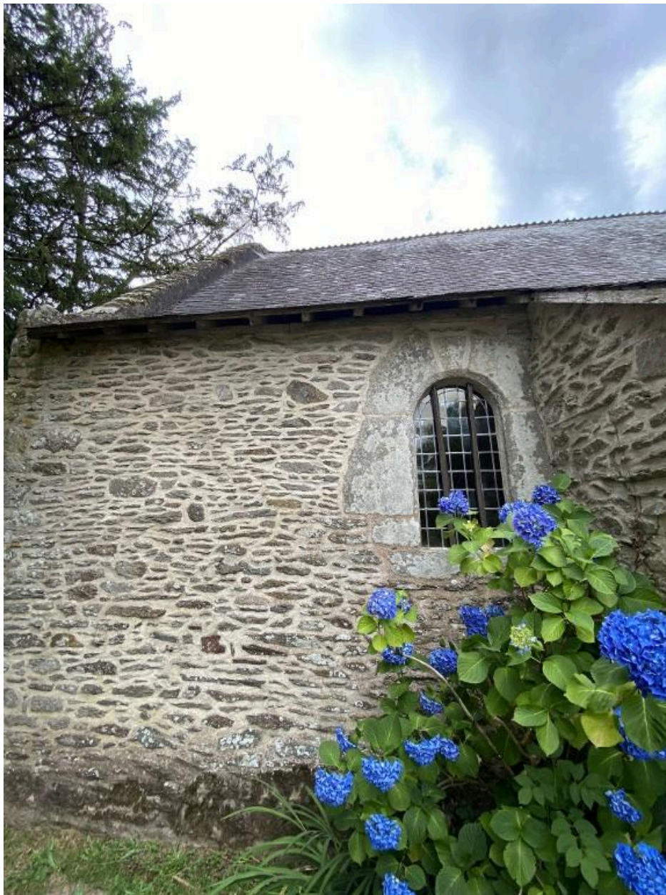
Élévation sud, détail
