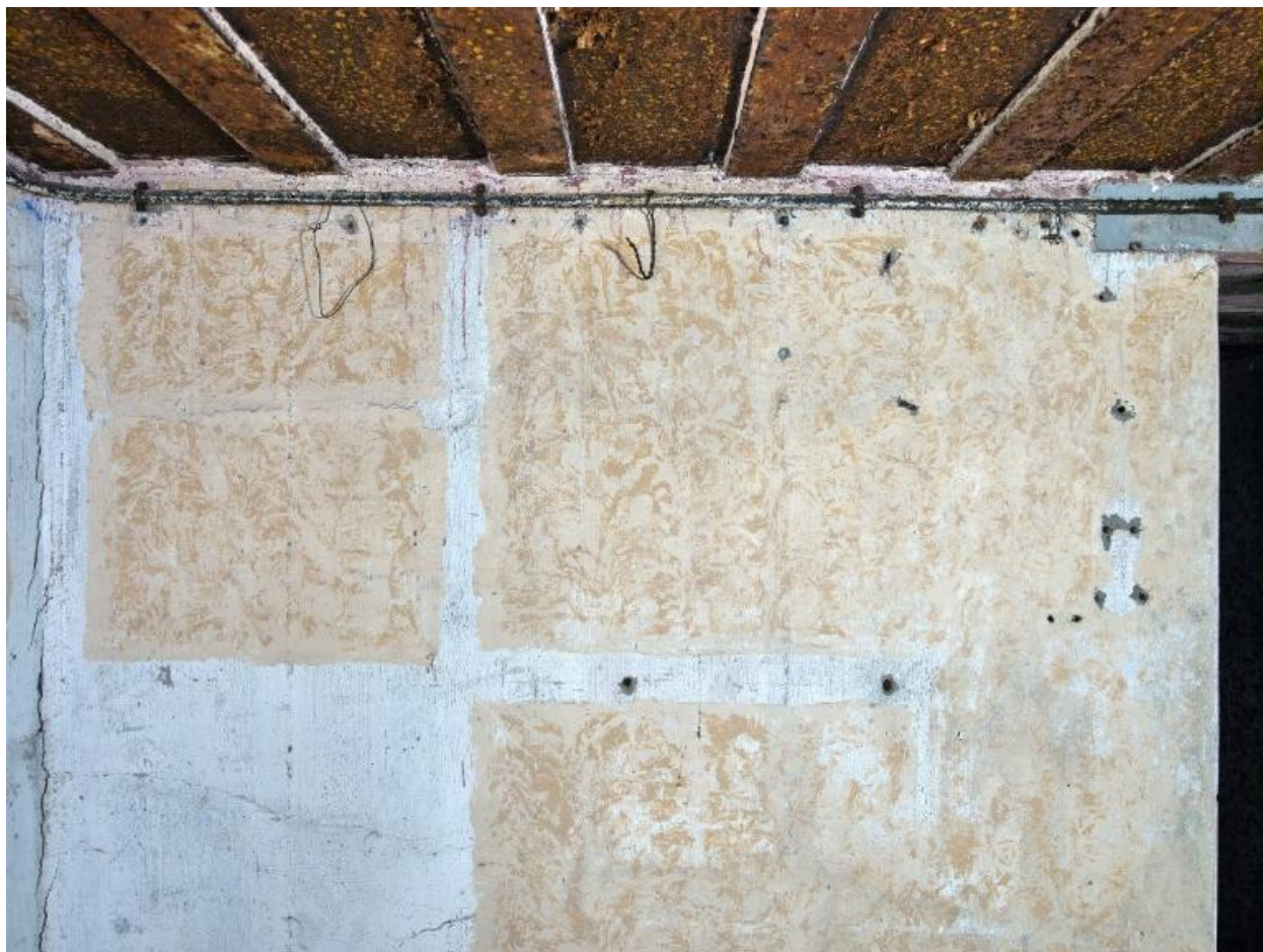
Vue du vestibule desservant les trois chambres de combat : détail de la peinture en chiffonnade imitant un papier peint
