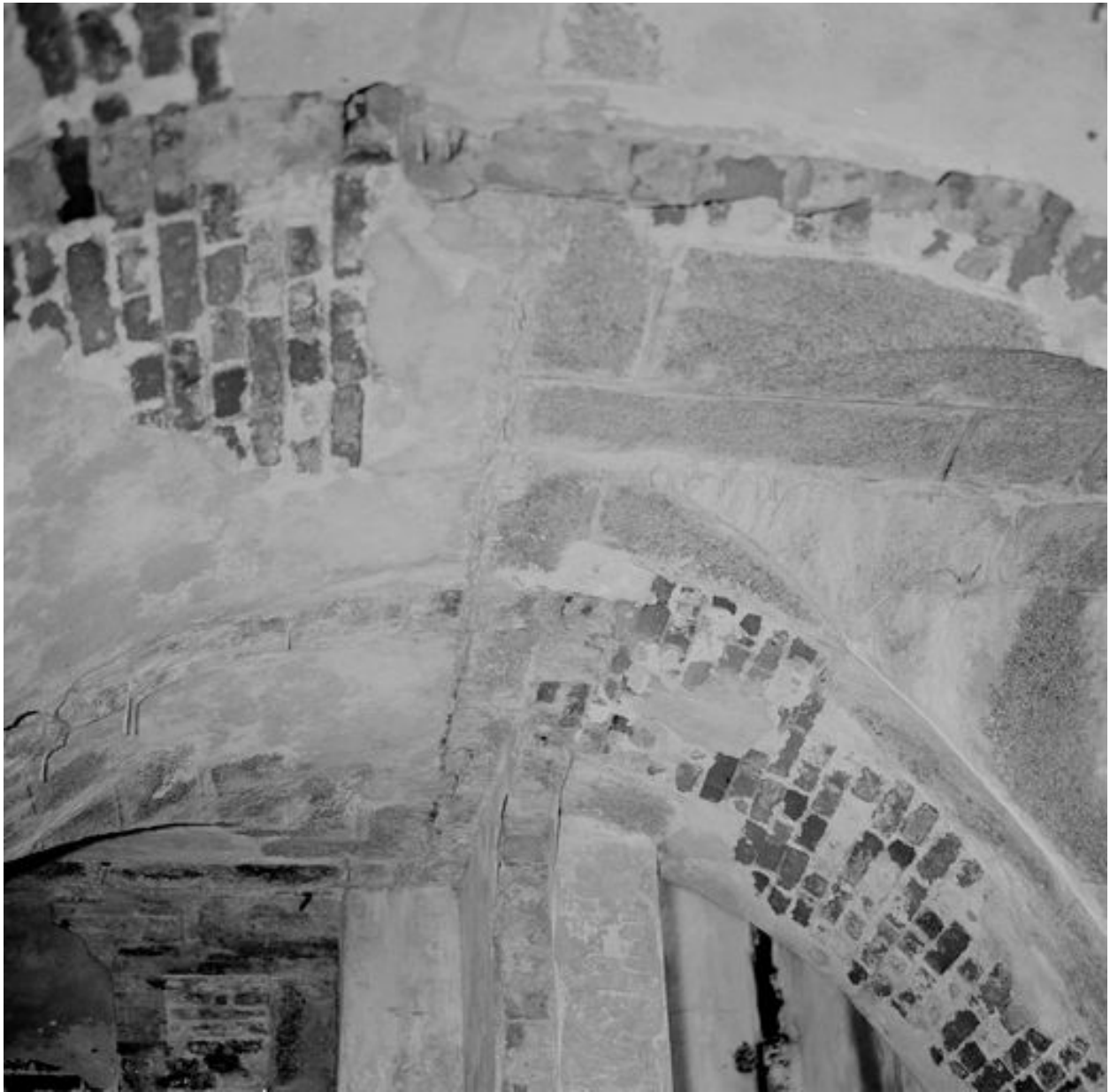
Camaret-sur-Mer, pointe du Toulinguet : vue de la tour-modèle n° 3 en 1969, détail de la voûte du premier niveau
