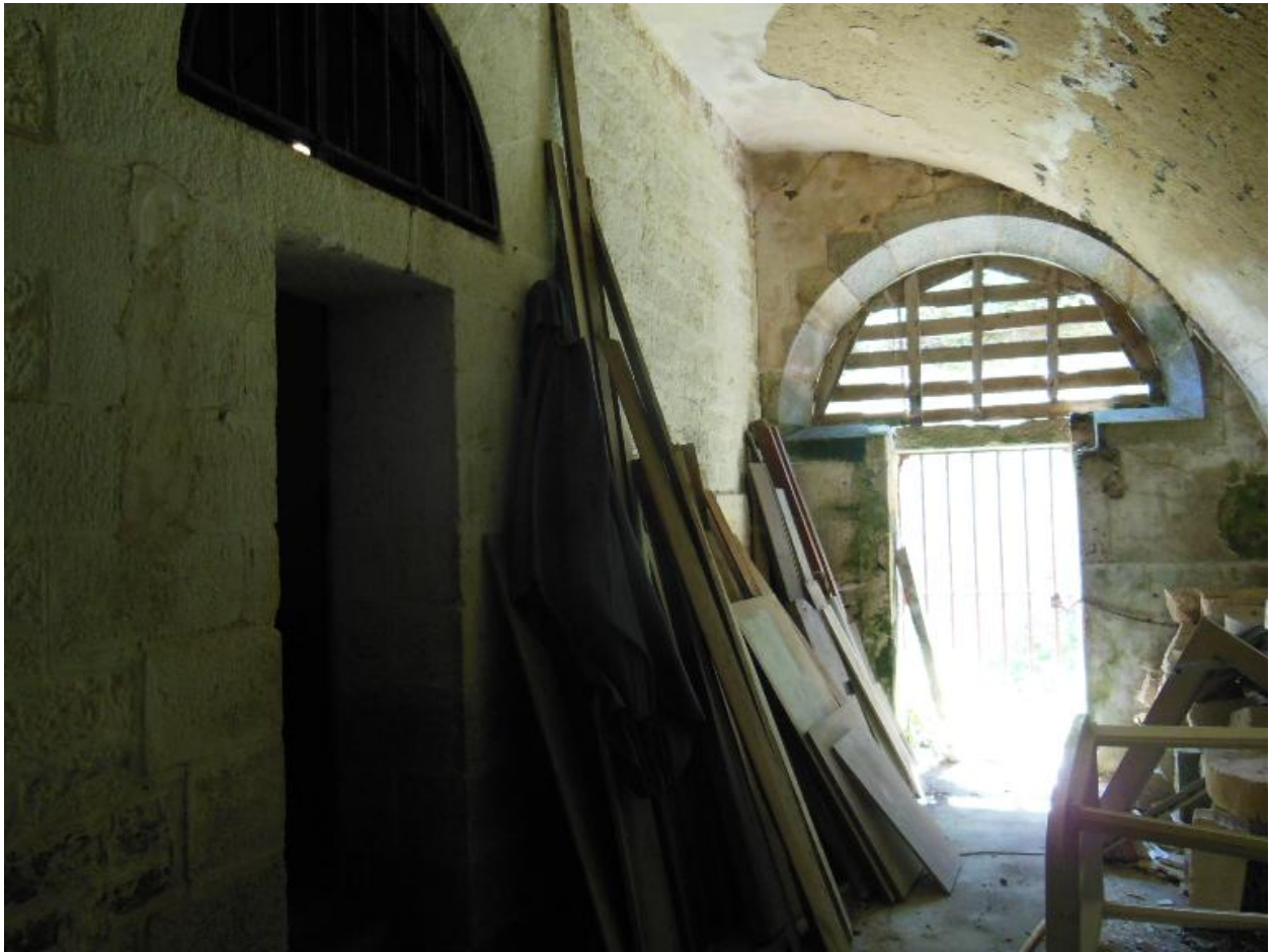
Le Palais, batterie du Gros Rocher, corps de garde crénelé, détail de la galerie voûtée d'enveloppe ouest.
