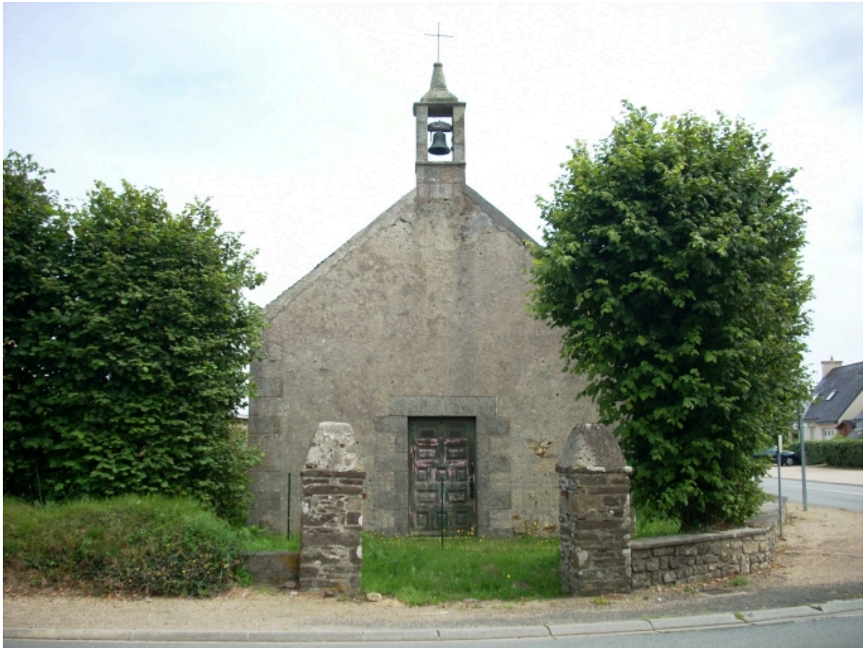
Plourin-lès-Morlaix, chapelle Saint-Michel : élévation ouest
