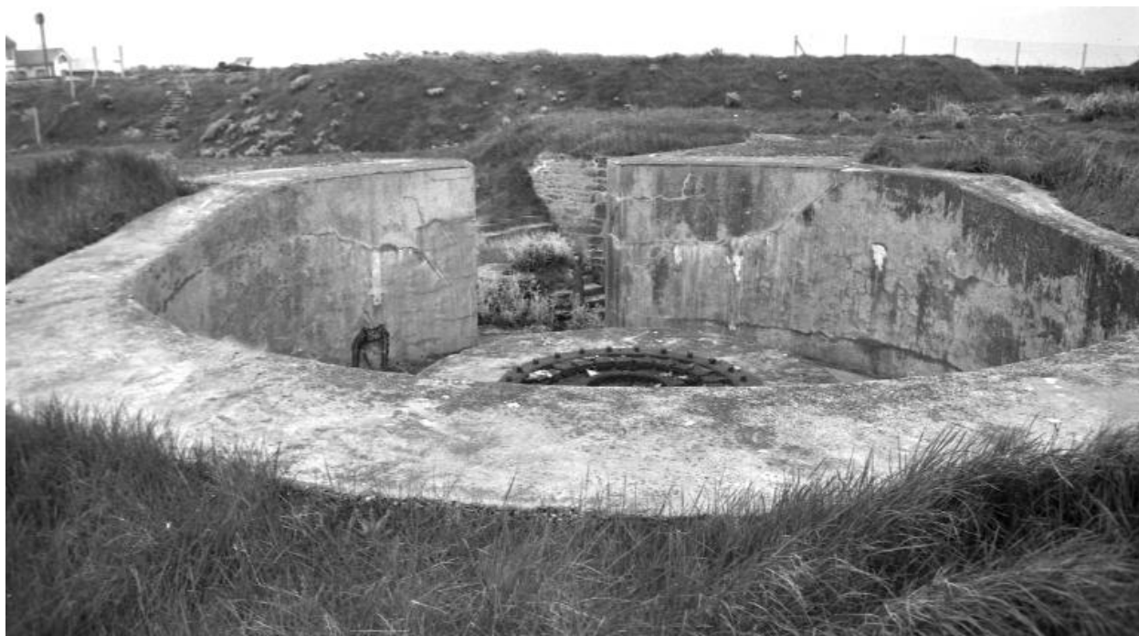
Batterie de 138, cuve de pièce
