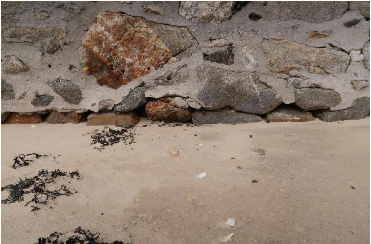
Cale de Porz Kernog, détail maçonnerie posée sur le sable : pierres différentes, mortier
