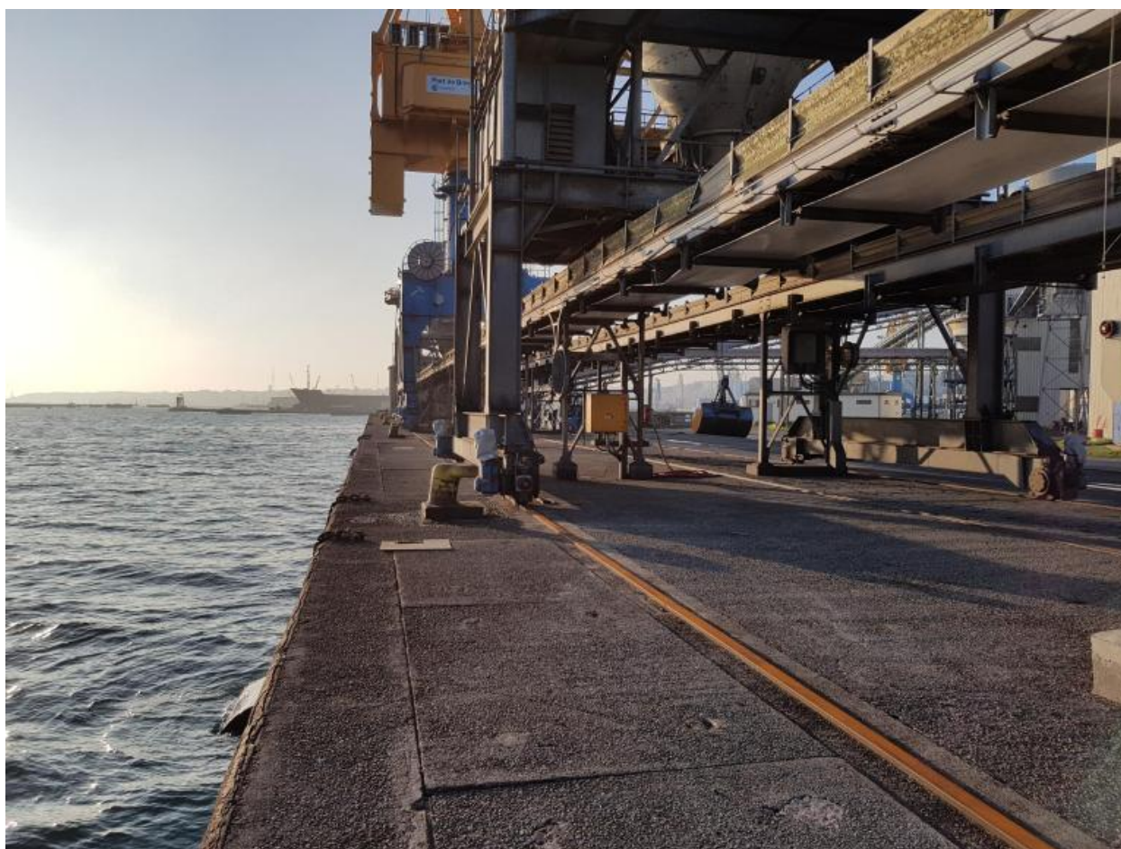
Quai 6 Sud : trémie, bandes transporteuse et rails des voies de grue
