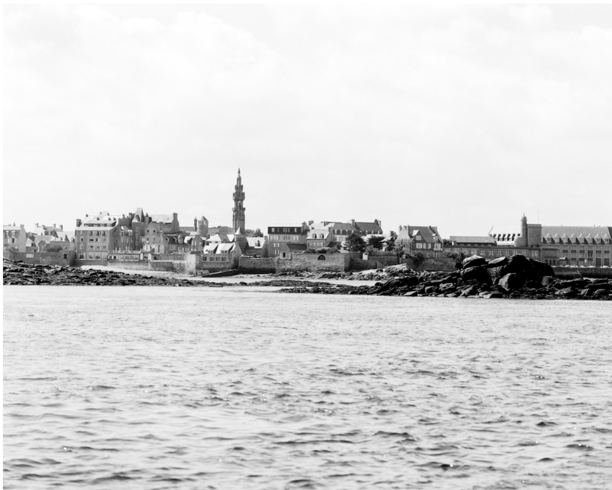
Maisons en front de mer, partie ouest, vue générale
