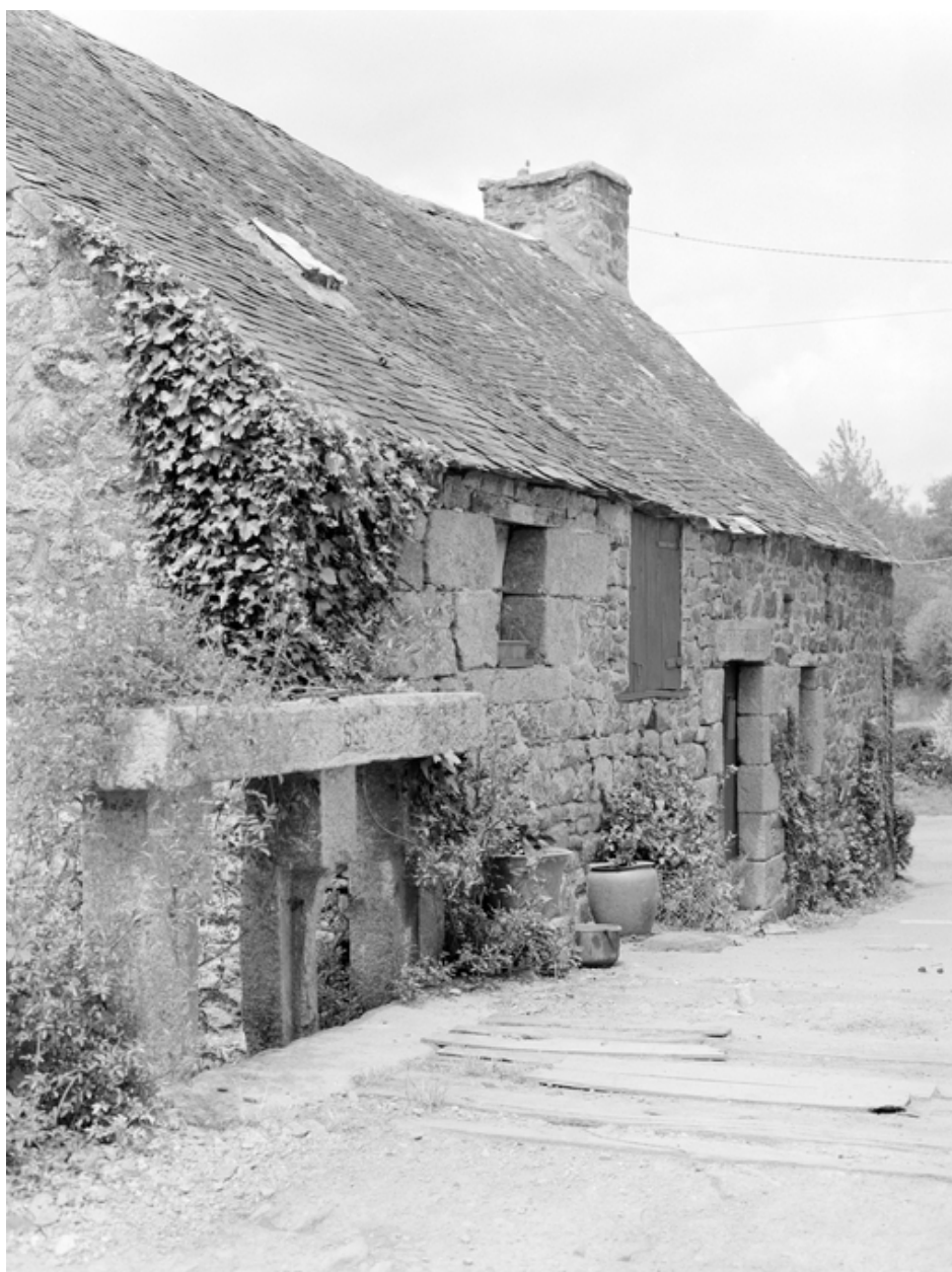
Vannage et moulin.
