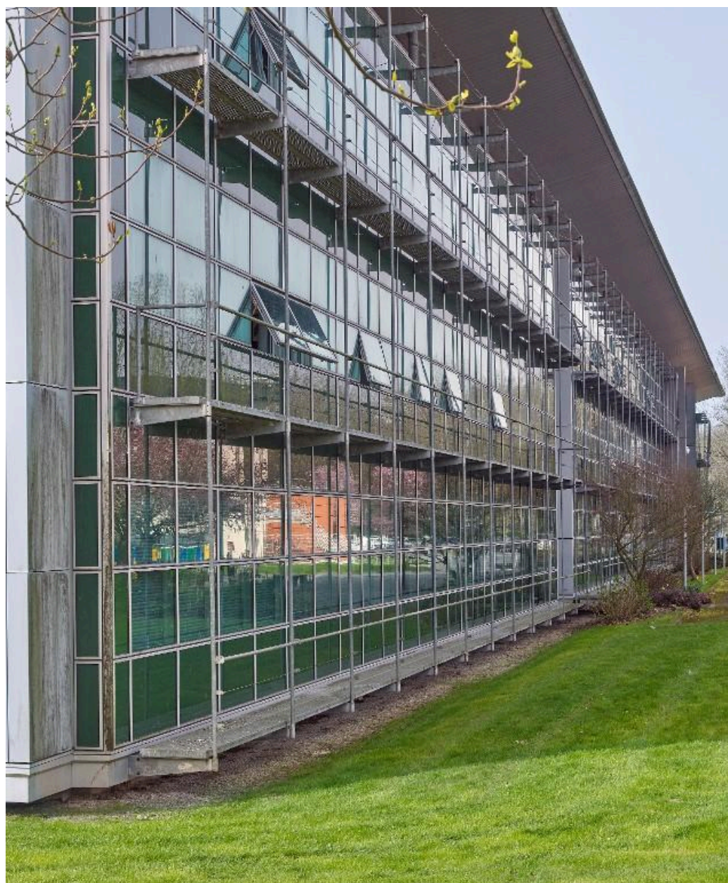
Façade nord du bâtiment principal. Joël Y. Gautier, architecte, 1992.
