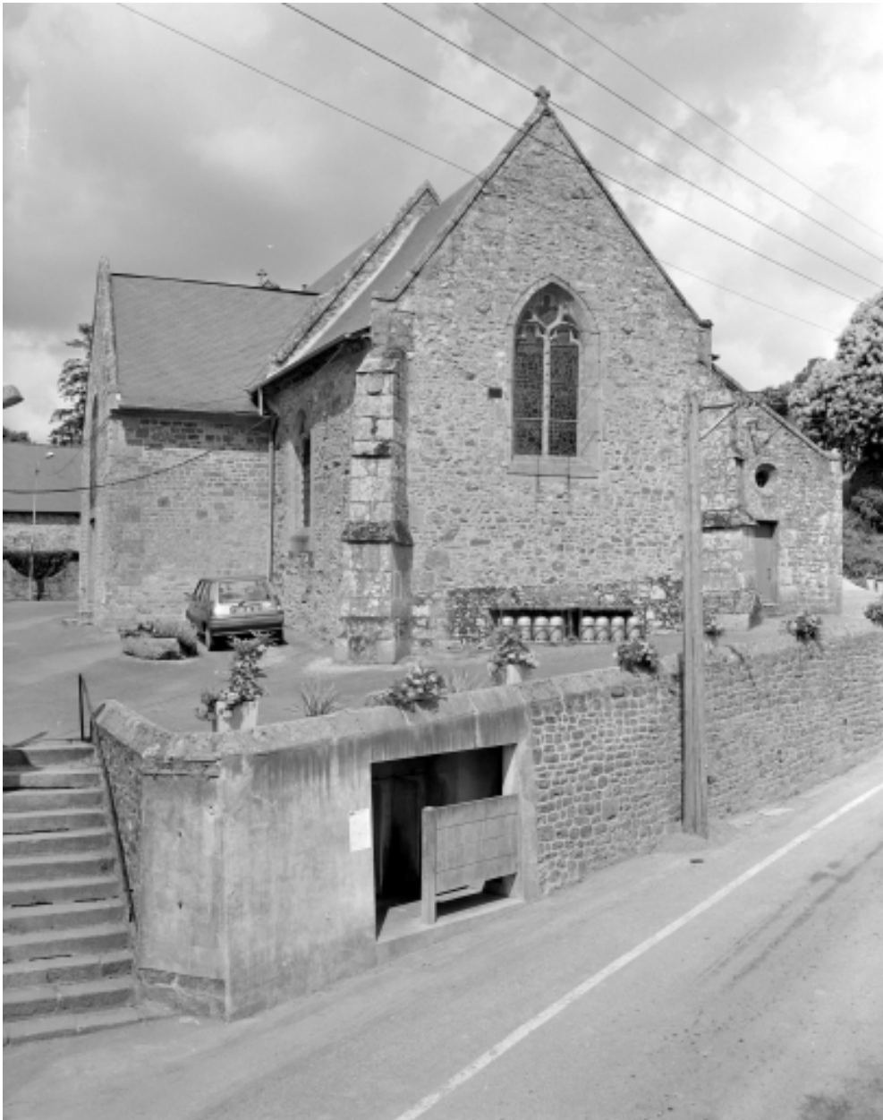
Elévation Est : vue générale
