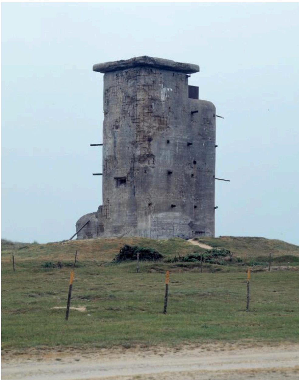
Vue générale du bunker - poste de direction de tir depuis le nord (état en 1994)
