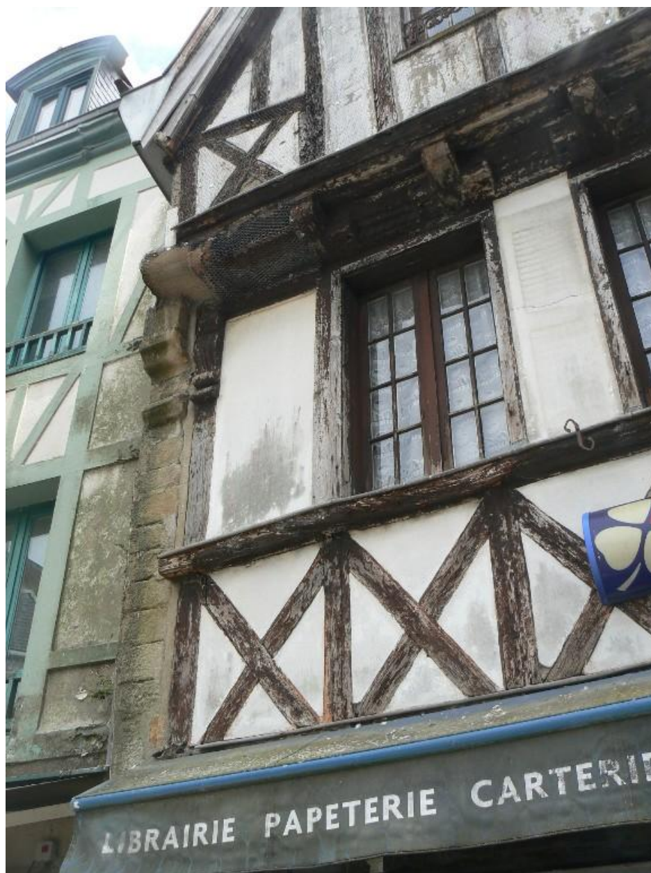
Détail des sablières d'encorbellement des croix de Saint-André
