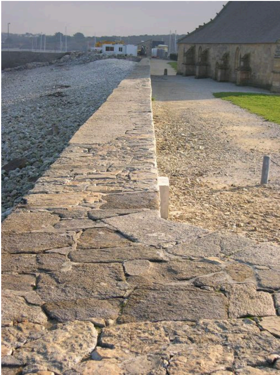
Vue de la digue vers l'est
