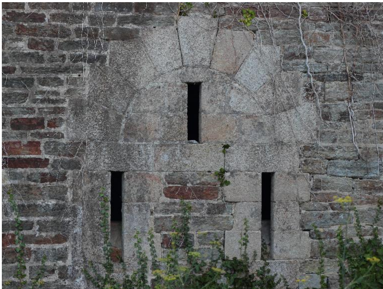
Locmaria, Grands Sables, batterie de La Ferrière, corps de garde crénelé, créneaux de tir.
