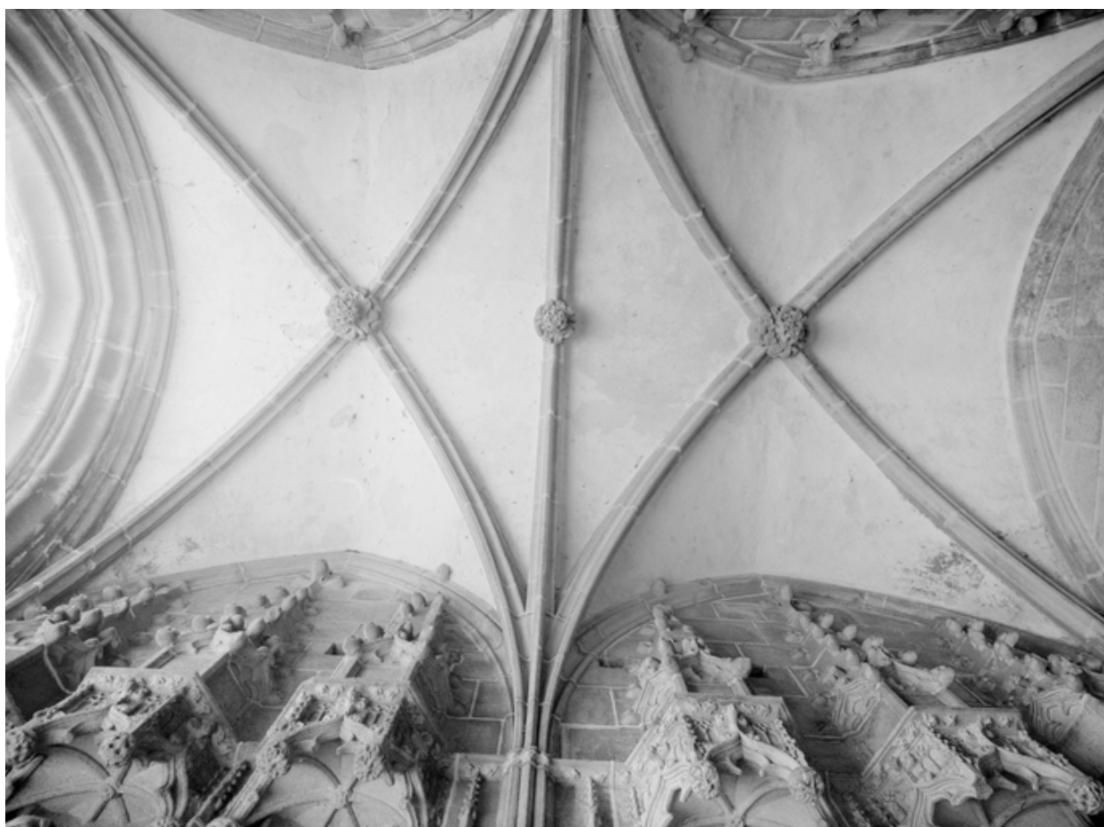
Porche sud de la nef, voûtes.
