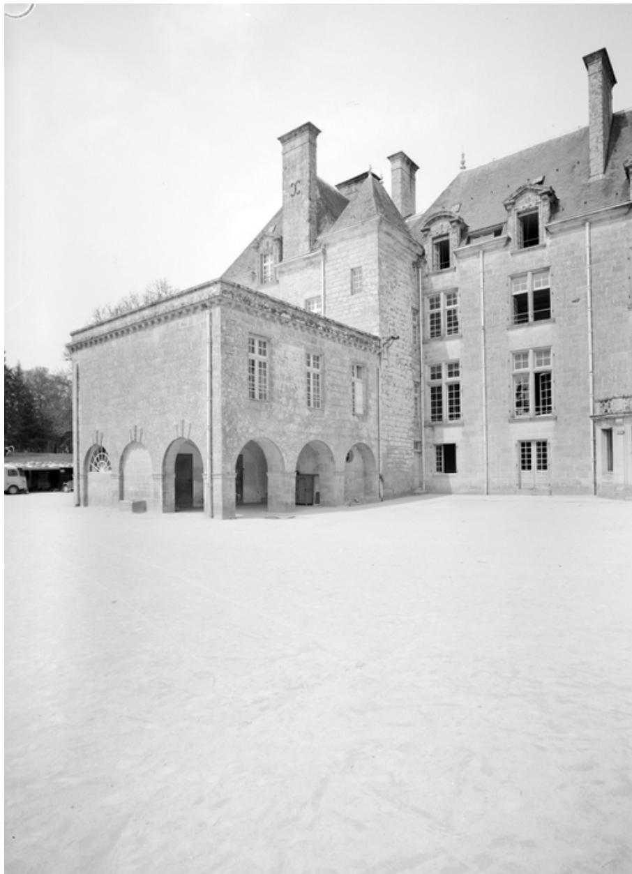
Vue de l'aile ouest (bâtiment à arcades en avant-corps)
