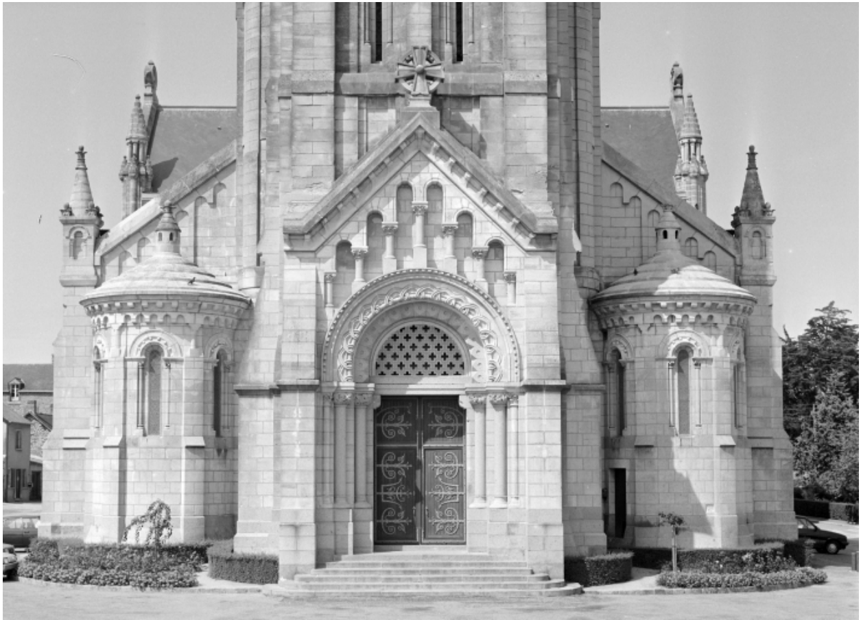
Elévation Sud, partie basse : vue générale
