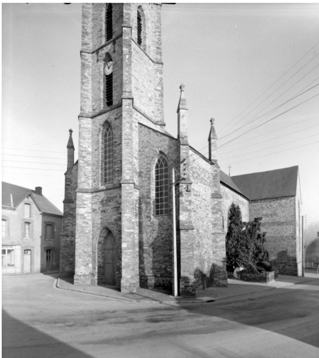
Elévation Sud-Ouest : vue générale
