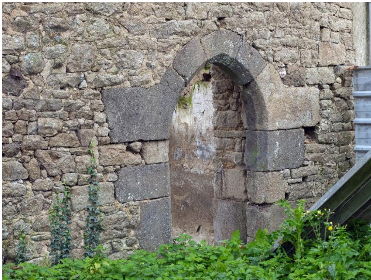
Vestiges. Façade arrière sud. Porte en arc brisé, 2e moitié 15e siècle
