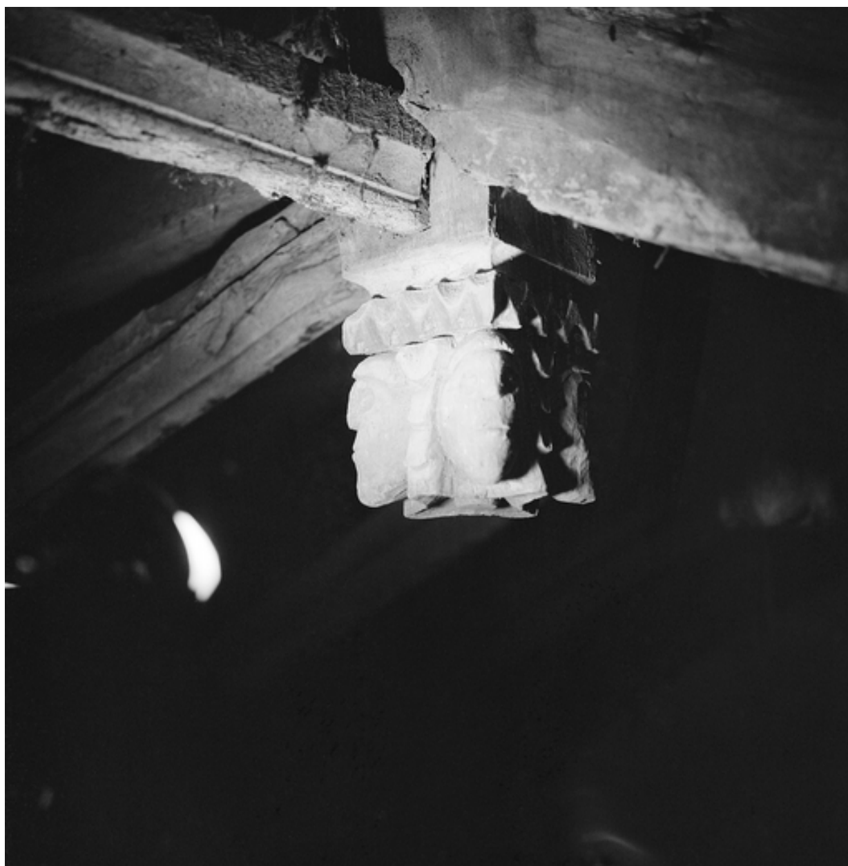
Charpente, détail de la clé 2.
