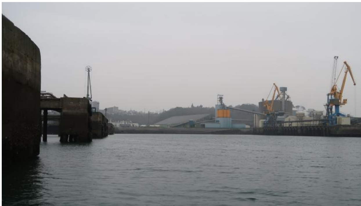
Le 6e bassin depuis le poste à huile vers le perré nord
