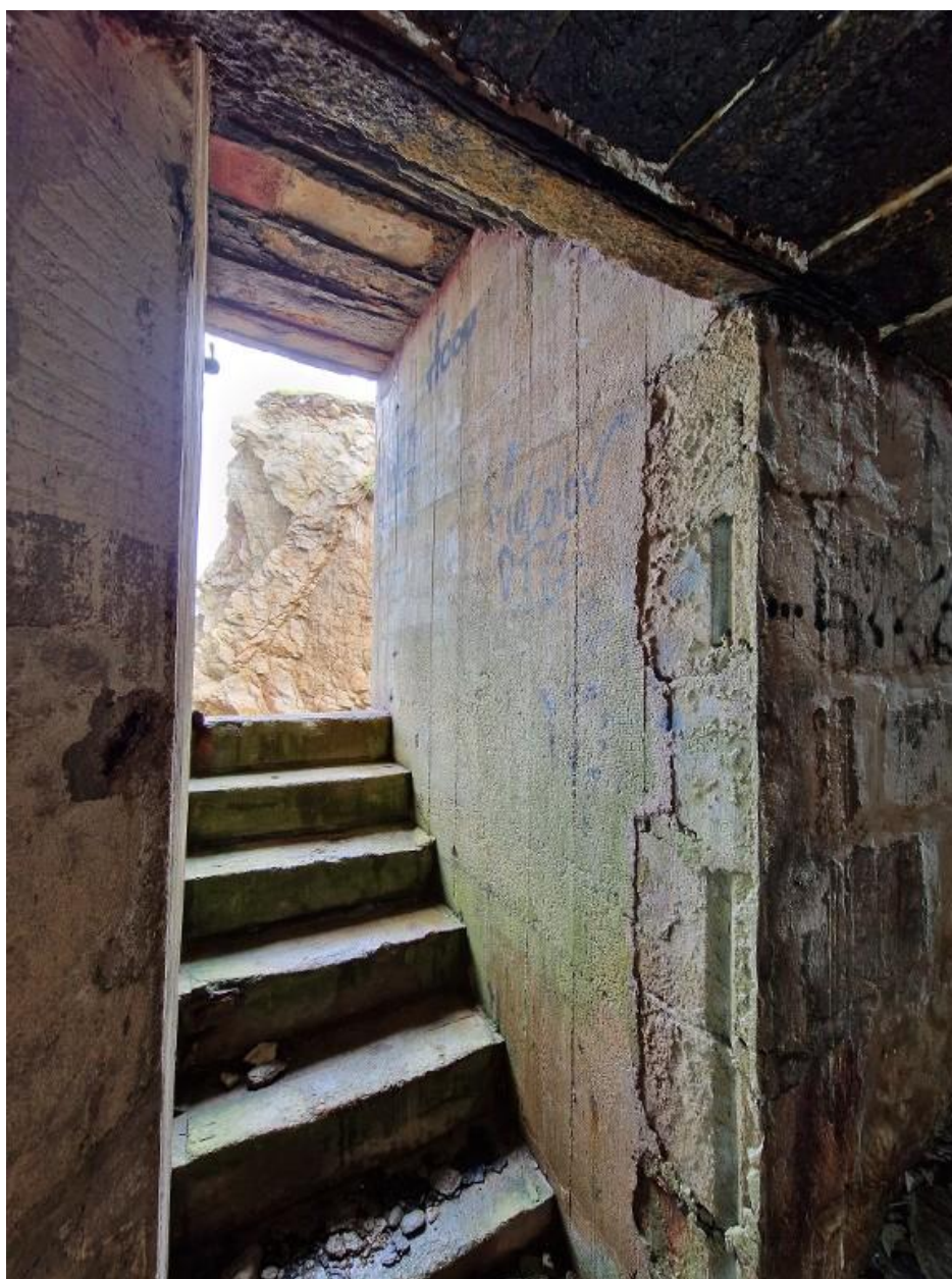
Vue intérieure : accès nord (entrée est). A gauche, pan coupé du couloir d'accès au sas
