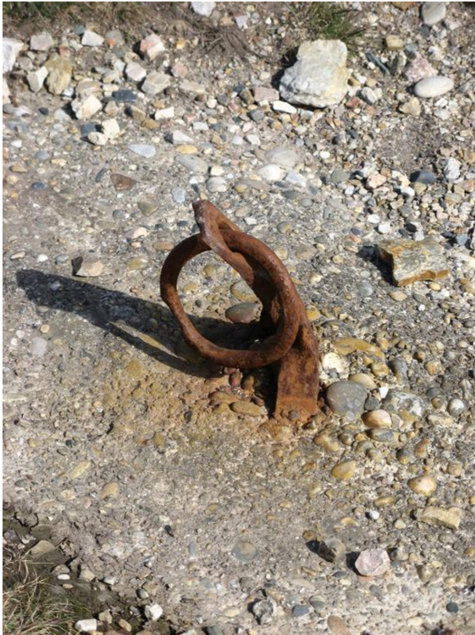
Anneau du poste de chargement de galets
